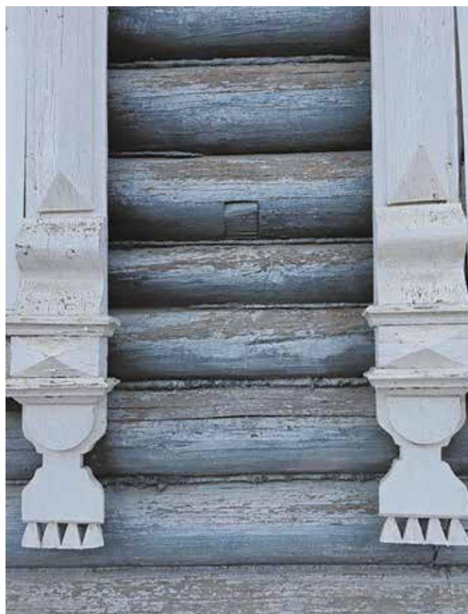
Повышенное разрушение ЛКМ на верхней четверти бревна под влиянием атмосферных воздействий и УФ излучения.
