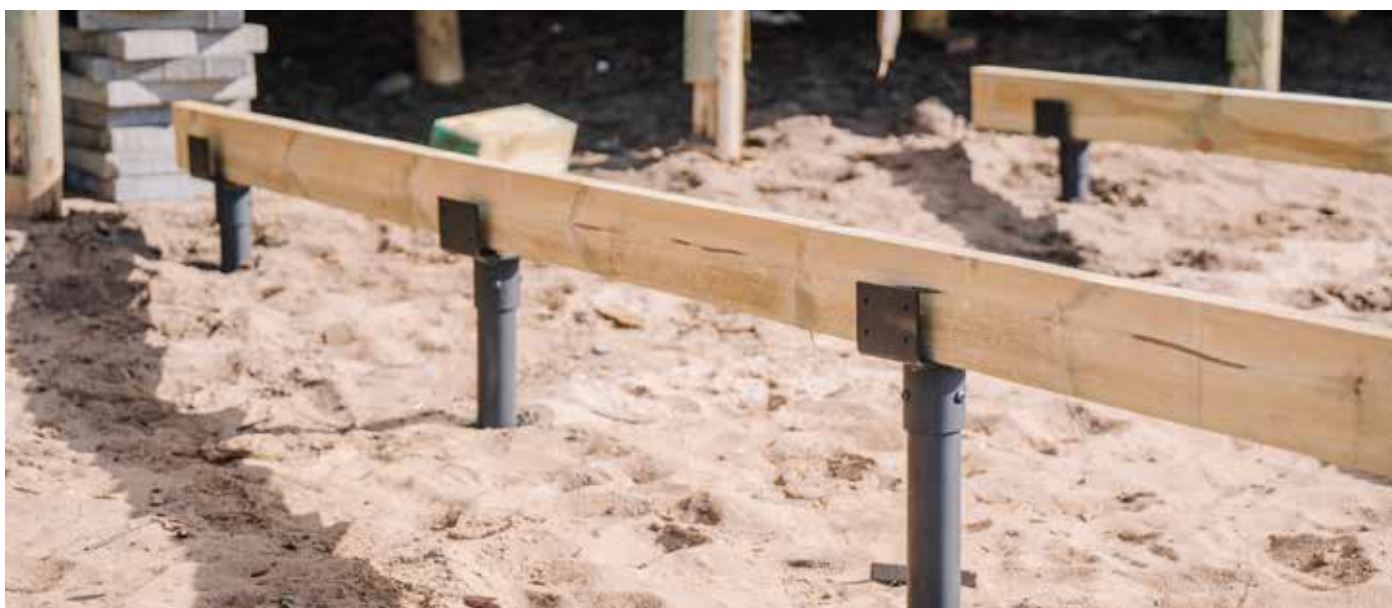
Монтаж деревянных лаг на металлические опоры требует обязательной изоляции дерева от прямого контакта с металлом.
