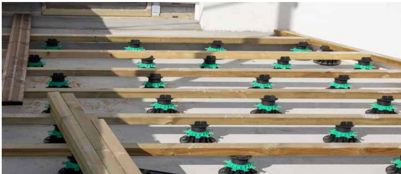
Монтаж деревянных лаг террасы на регулируемые опоры.
