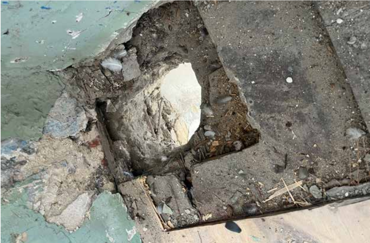
Фото 9. «Здание, в котором в 1943 г. размещался Штаб 61 Гвардейской Свердловско-Львовской танковой бригады, сформированной из уральцев-добровольцев» по ул. Блюхера, 5а. Железобетонное перекрытие, армированное гладкой арматурой. (личный архив Удаловой Ю.В.).
