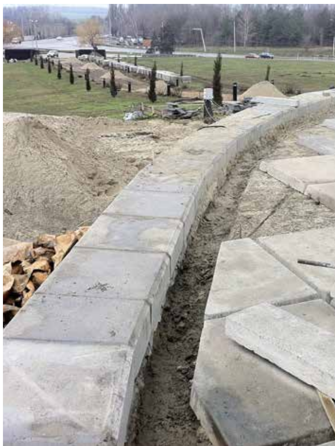
Фото 9. Проведение работ по реставрации Мемориала.
