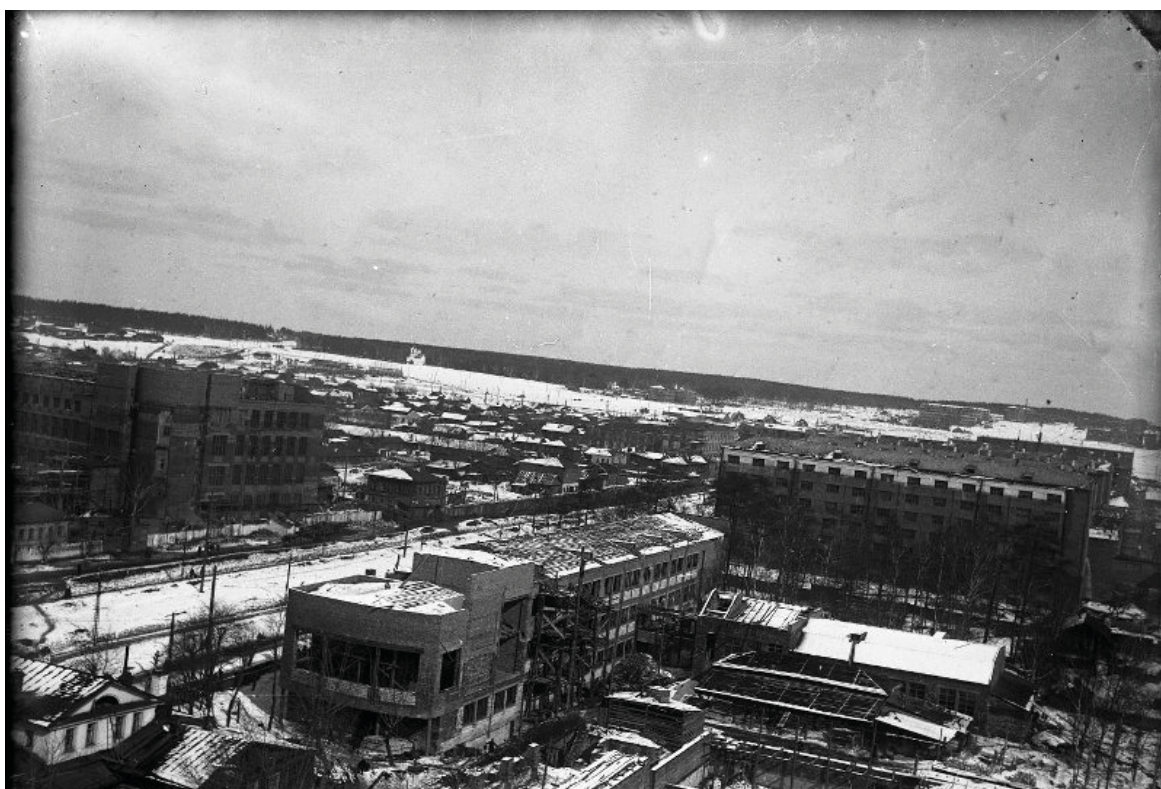
Фото 3. Вид на здание гостиницы «Киностудии» и здания домов Госпромунала. Негатив. Город Свердловск. Панорама строительства городка чекистов и домов госпромунала в 1930-м году. Источник: Госкаталог. Номер в Госкаталоге: 41616196 Местонахождение: Государственное автономное учреждение культуры Свердловской области "Свердловский областной краеведческий музей имени О. Е. Клера".
