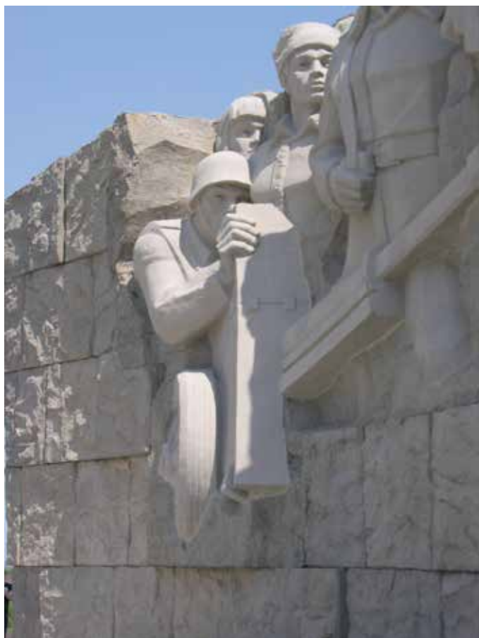
Фото 12. Состояние Мемориала после реставрации.
