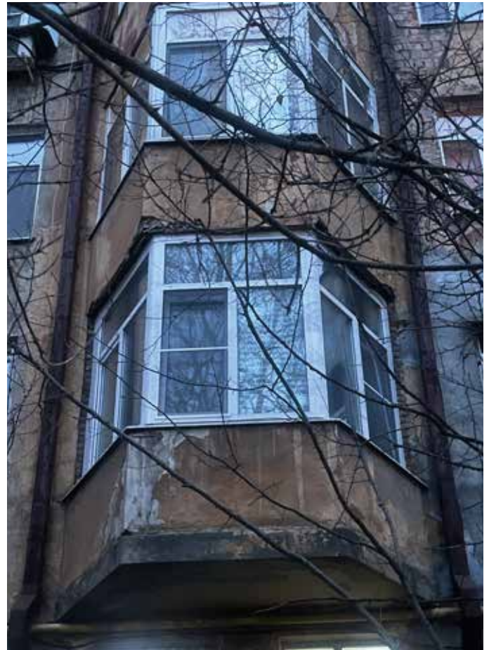
Фото 4. Фрагмент дворового фасада здания «Жилой дом» по ул. Луначарского 69, являющейся частью «Городка Чекиста». Дощатые конструкции эркера, оштукатуренные по дранке. (личный архив Удаловой Ю.В.).
