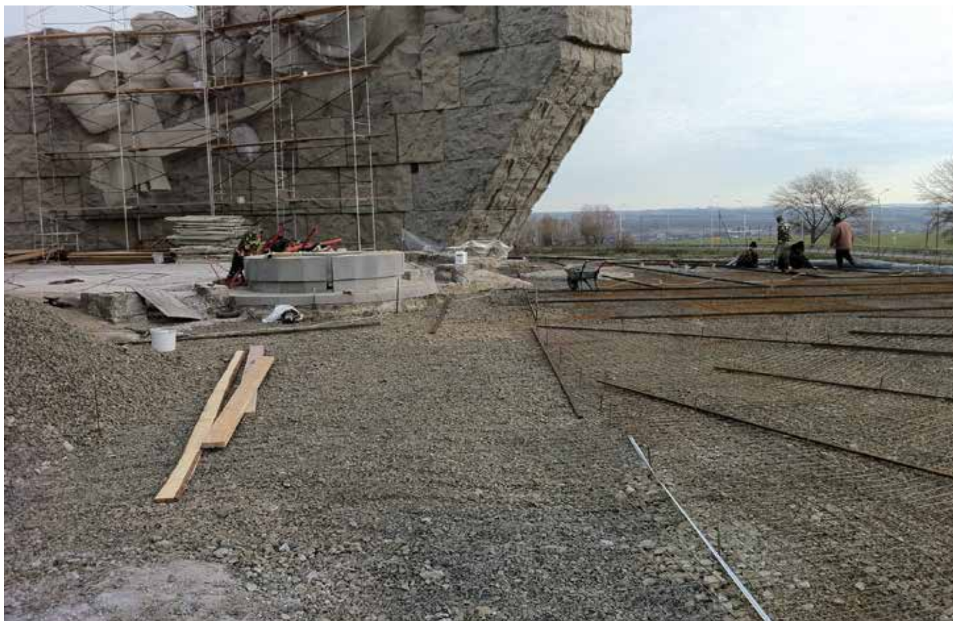
Фото 8. Проведение работ по реставрации Мемориала.
