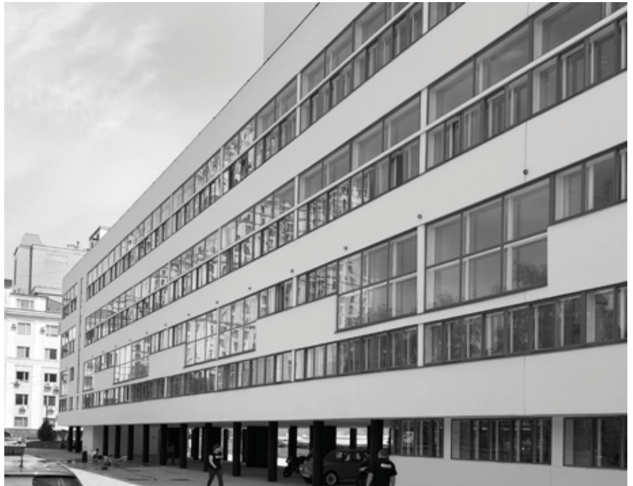
Западный фасад после окончания реставрационных работ. 2020. ООО «Гинзбург Архитектс».
