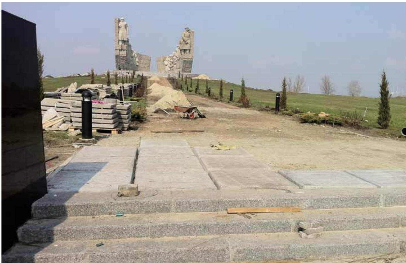
Фото 5. Проведение работ по реставрации Мемориала.
