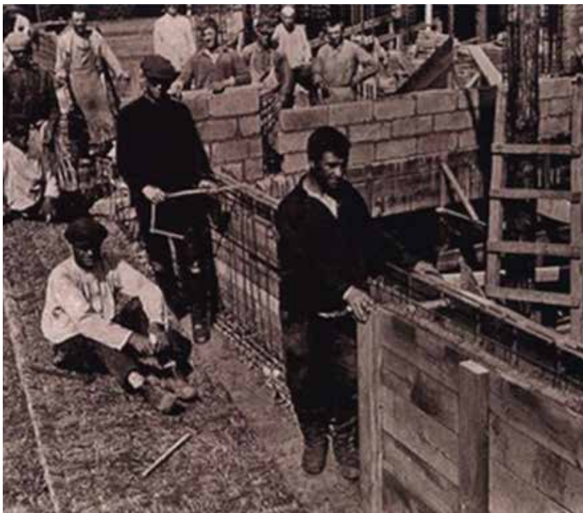
Устройство опалубки. Фотография со стройки. 1930. Архив семьи Гинзбургов.
