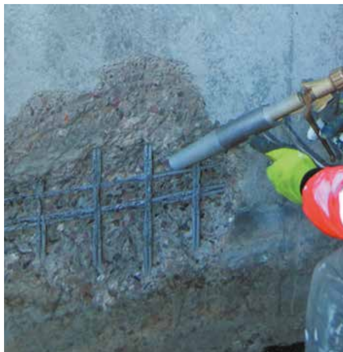
Фото 8. Подготовка поверхности арматуры.
