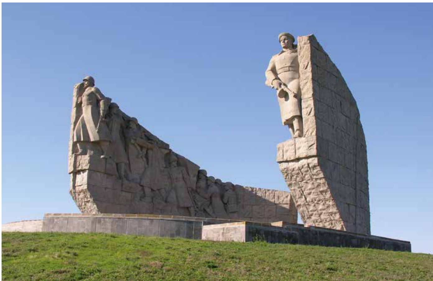
Фото 1. Состояние Мемориала до проведения работ.
