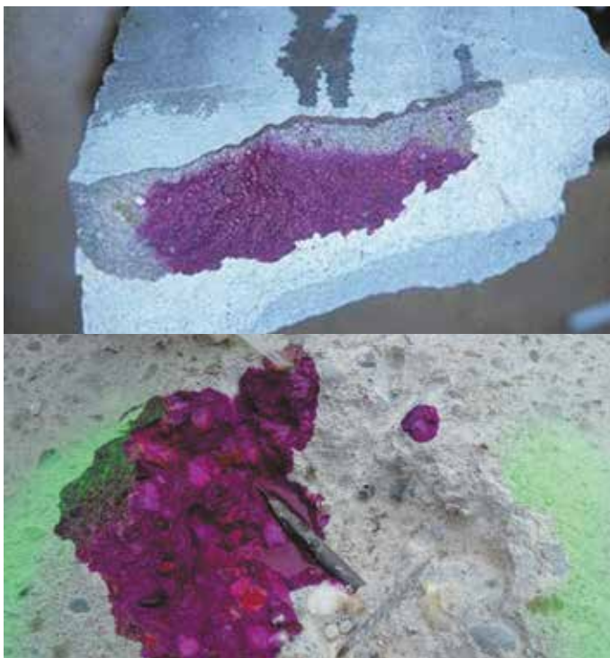
Фото 6. Определение глубины карбонизации бетона.
