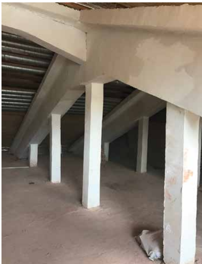
Фото 5. Вид железобетонных ферм в подкровельном пространстве здания «Завод аффиный: производственный корпус» в процессе реставрационных работ. (личный архив Удаловой Ю.В.).
