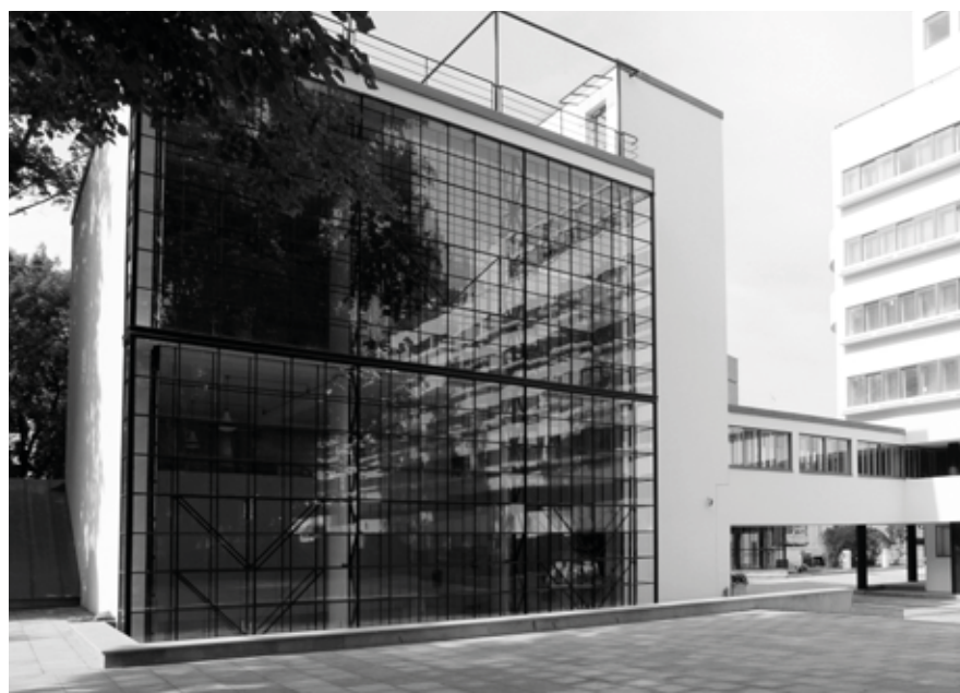
Витраж коммунального корпуса после окончания реставрационных работ. 2020. ООО «Гинзбург Архитектс».
