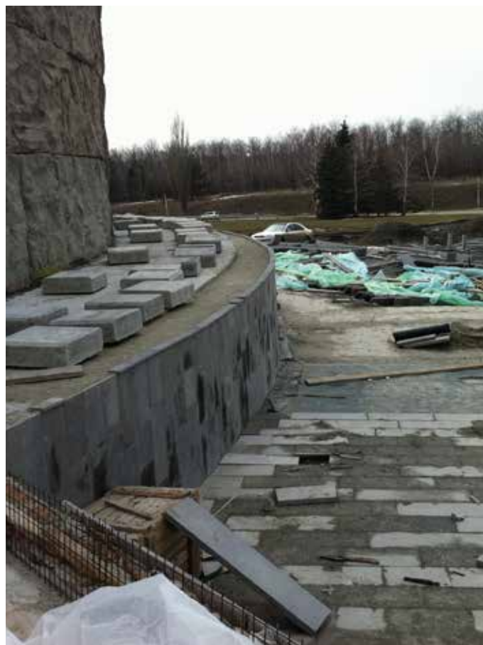
Фото 7. Проведение работ по реставрации Мемориала.
