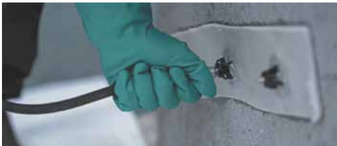
Фото 9. Нагнетание эпоксидных смол.
