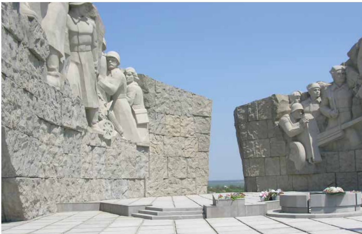
Фото 11. Состояние Мемориала после реставрации.
