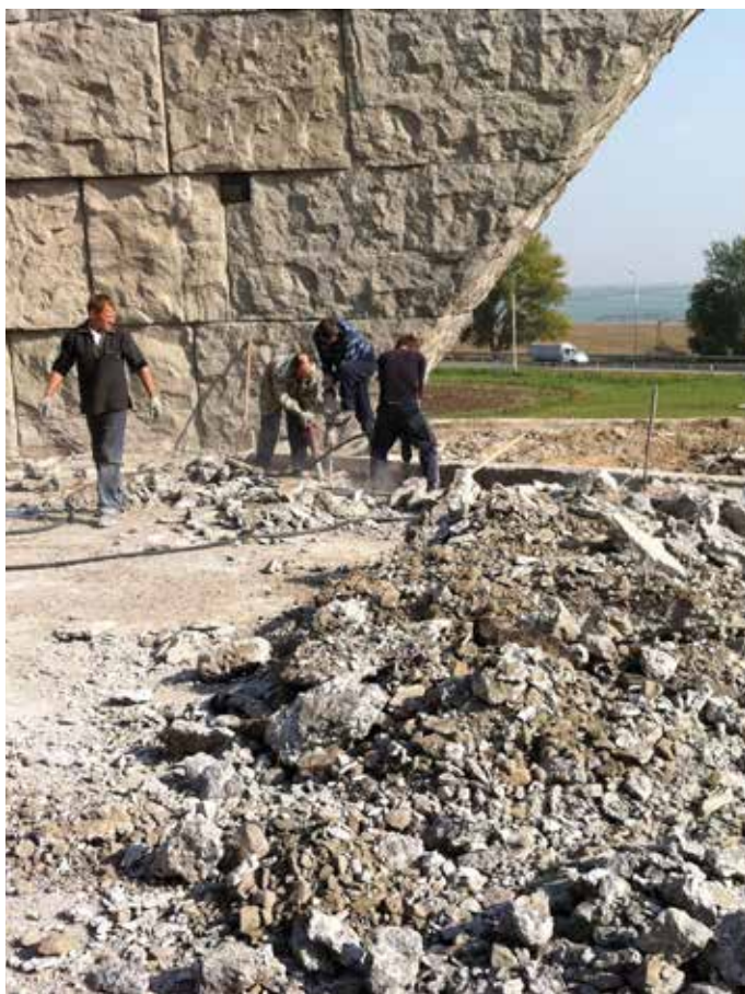
Фото 6. Проведение работ по реставрации Мемориала.
