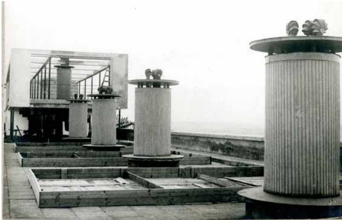
Эксплуатируемая кровля жилого корпуса с цветочницами, установленными на тротуарную плитку. 1930. Архив семьи Гинзбургов.
