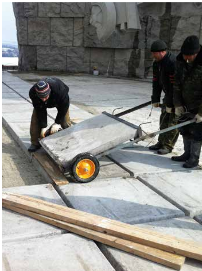
Фото 10. Проведение работ по реставрации Мемориала.
