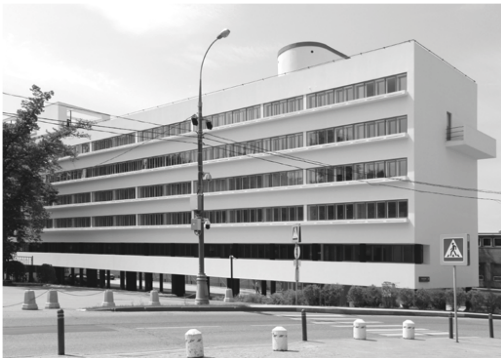
Восточный фасад после окончания реставрационных работ. 2020. ООО «Гинзбург Архитектс».
