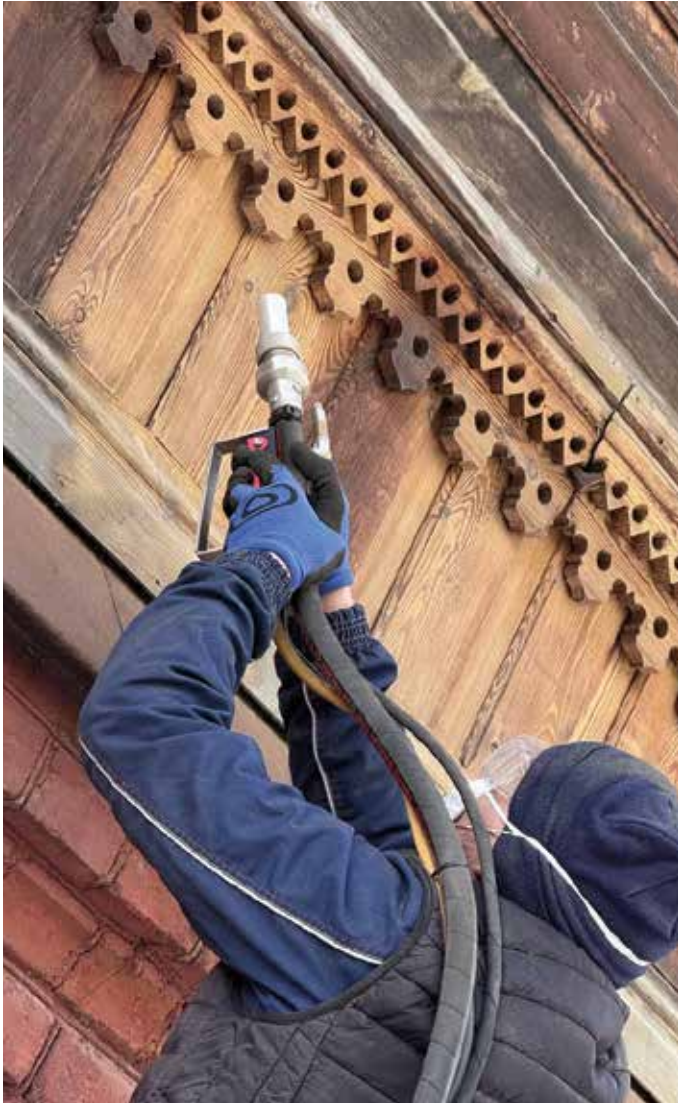
Фото 2. Очистка древесины струйно-вихревым абразивным методом (технология rotec®).
