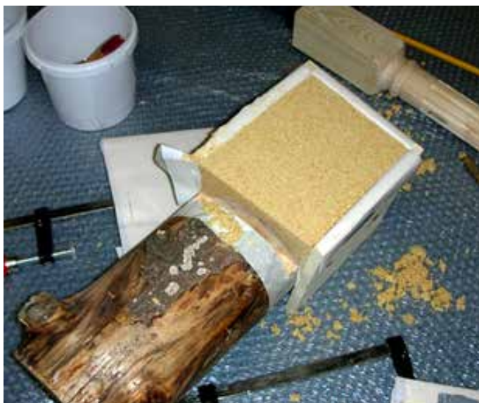
Фото 3. Промежуточный этап докомпоновки утрат древесины составом на полиуретановой основе перед последующей обработкой.
