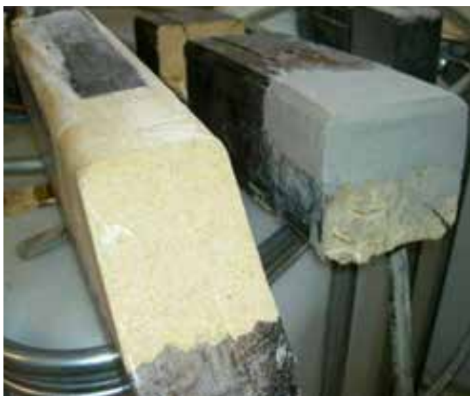
Фото 4. Выполненная докомпоновка деревянного элемента составом на полиуретановой основе (слева) и на эпоксидной основе (справа).
